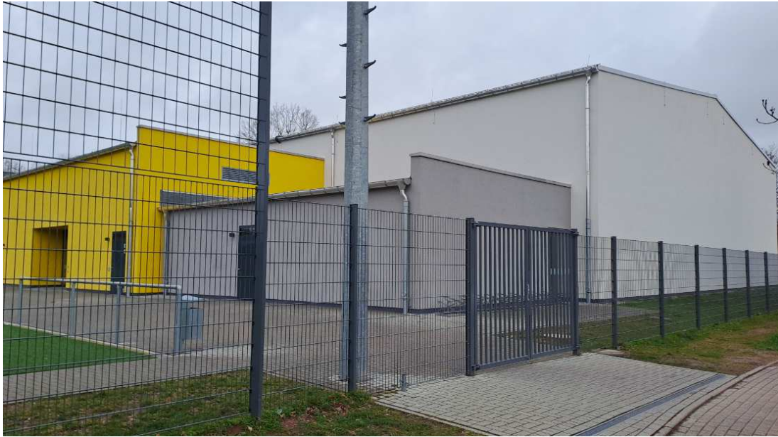
Sporthalle West - Süd-/Ostansicht
